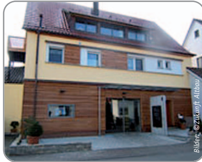
■ Nach der Altbausanierung
