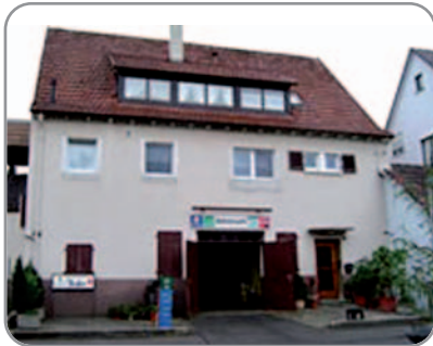
■ Vor der Altbausanierung
